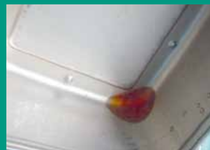
Krvavý kondenzát na dně vany
